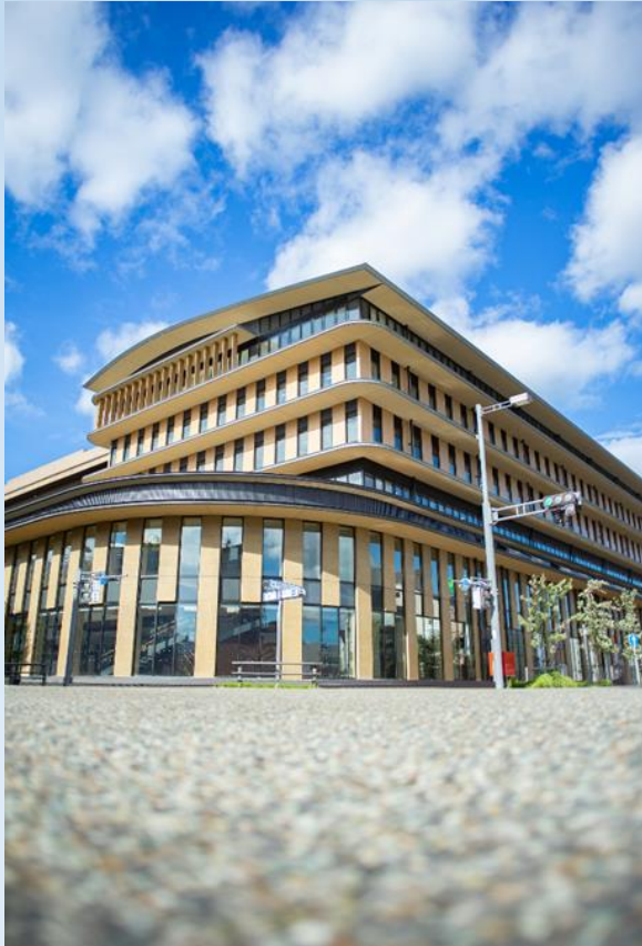
完成した各務原市役所新庁舎高層棟
