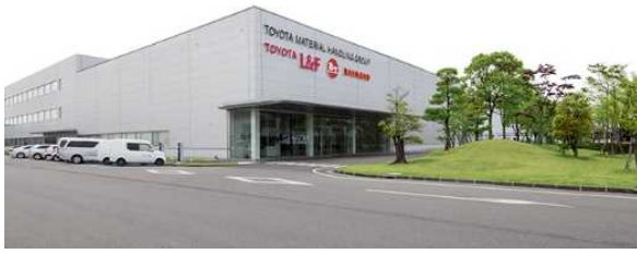
高浜工場外観
