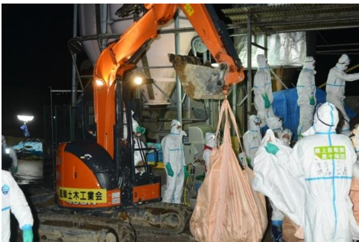
夜間作業の景況
