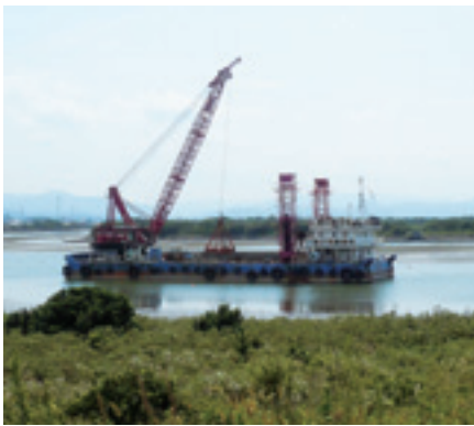
土砂の浚渫作業
