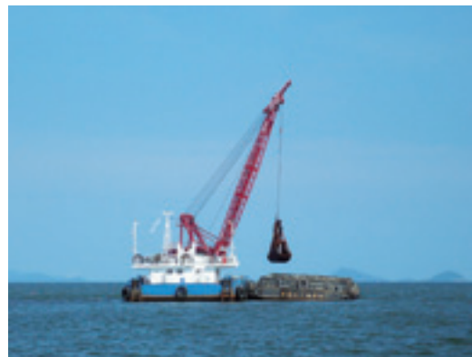
浚渫土砂の海上投棄
