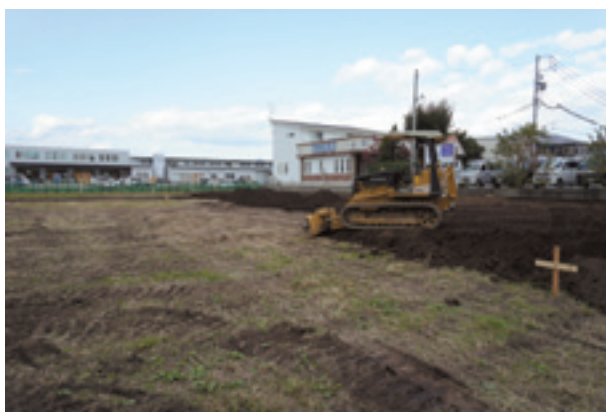
造成中の現場
