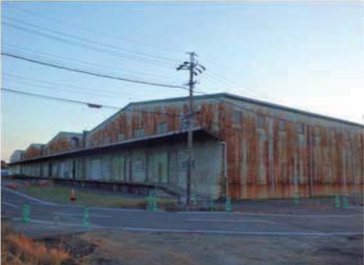
既設補給倉庫(昭和28年建設)
