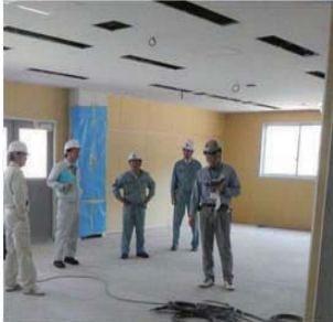
当支局監督官による倉庫内事務室の内装仕上確認
