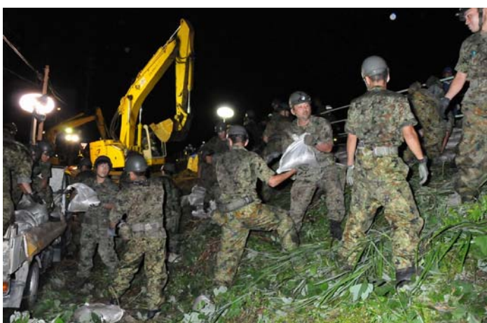
水防作業（八田川）
