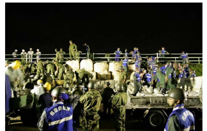
水防作業（八田川）
