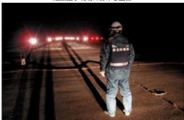
被災した松島基地の航空灯火施設の応急復旧作業
