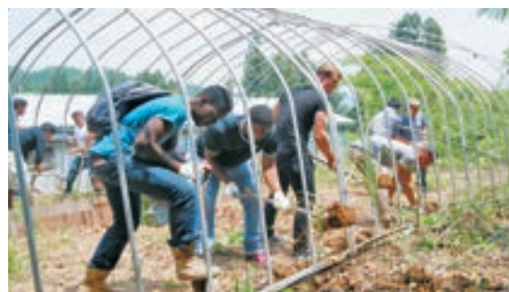
ビニールハウスの撤去作業を行う隊員
