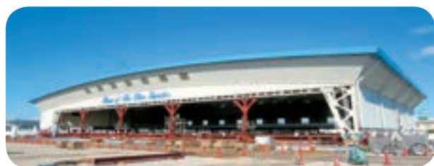
自衛隊施設の建設（ブルーインパルス格納庫）
