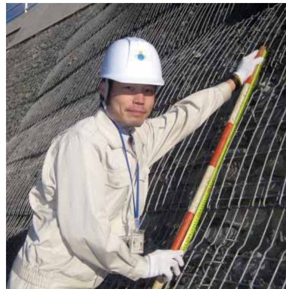
土木工事現場確認風景
