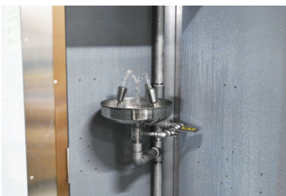
大量の柔らかい水流によって有害物質を洗い流す洗眼器
