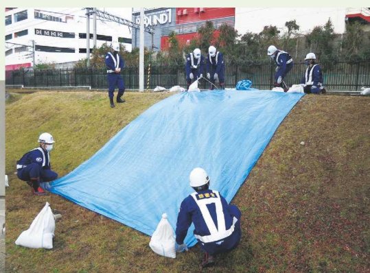
斜面の崩落防止のため ブルーシートで養生
