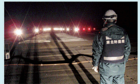
応急復旧工事の様子
