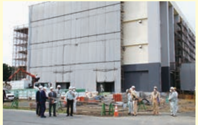
北部航空方面隊司令部庁舎建替え現場
