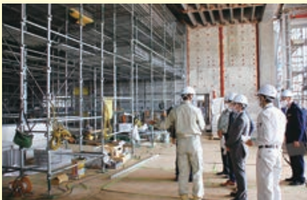
F-35整備試験運転時の騒音防止消音装置「サイレンサー(機体用)」の改修現場
