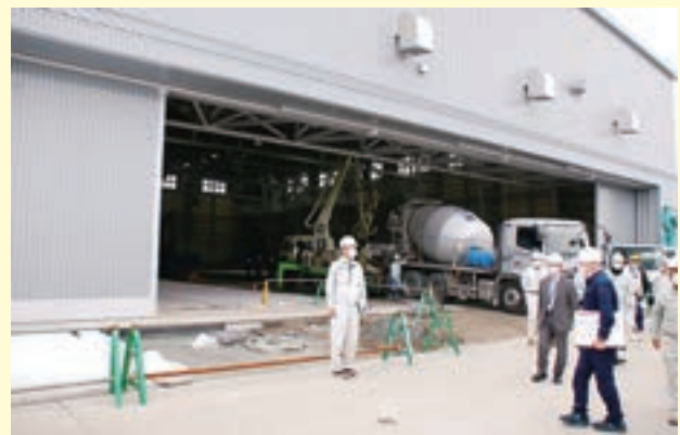
滞空型無人機「グローバルホーク」の格納庫新設現場
