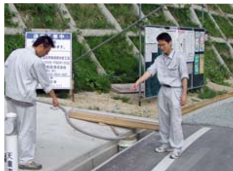
(道路改修事業の現場)
