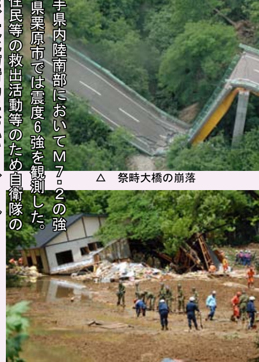
△ 被災した旅館(駒の湯温泉)
