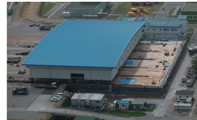
基礎を約3.5mの高さまで嵩上げし(右側)、曳家工事中
