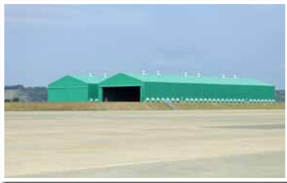
高台化した2棟の仮設格納庫
