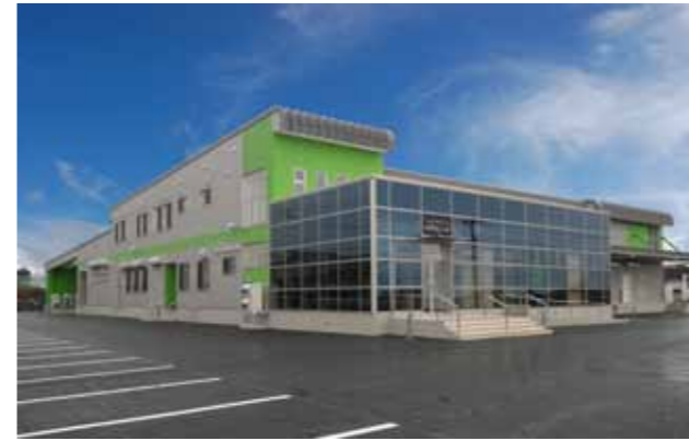
△ 完成した農産物加工施設
