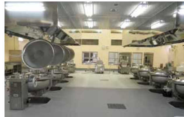
△ 農産物加工施設1階の調理室
