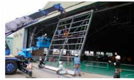
△ 大扉の設置作業
