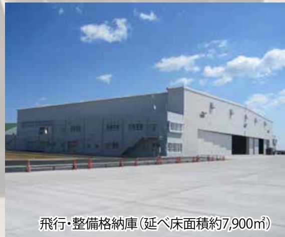
曳家工法により高台化されたブルーインパルス用格納庫(延べ床面積約3,300㎡)
