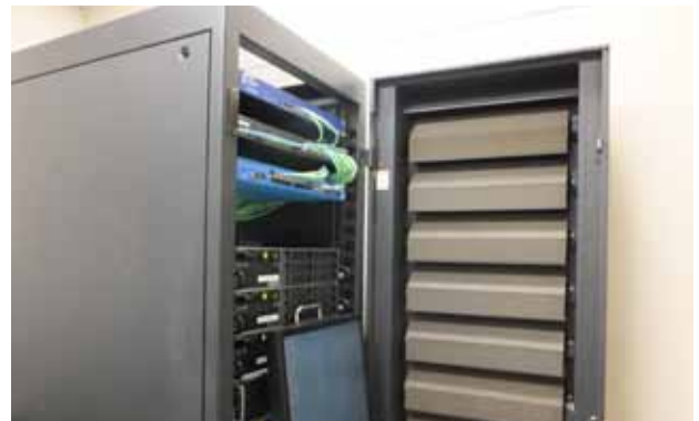
O Aネットワーク復旧作業
