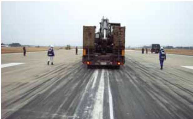
大型重機を載せたトレーラーによる「たわみの調査」
