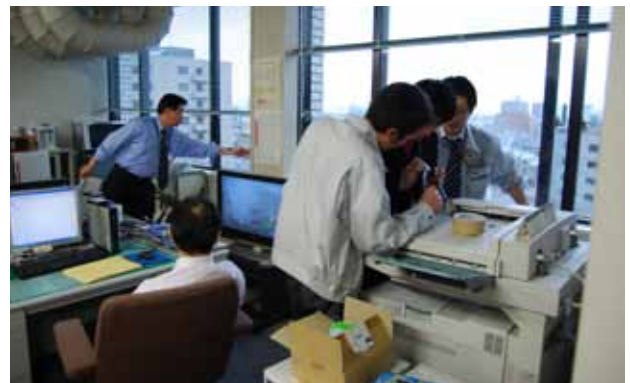
OA ネットワーク復旧作業
