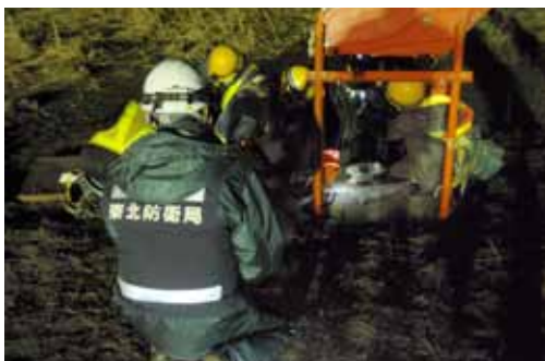
灯火機器設置工事の様子
