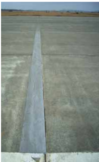
補修完了確認
