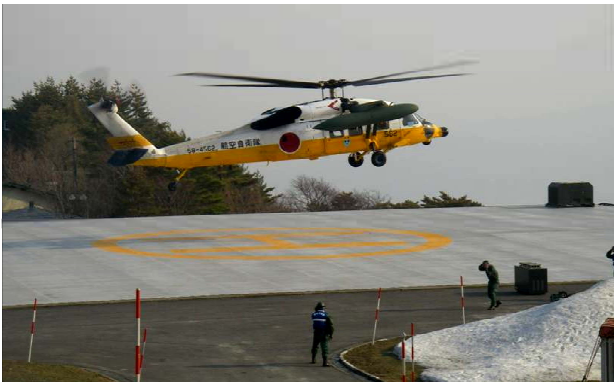
ヘリポートの被害状況調査(山田分屯基地)
