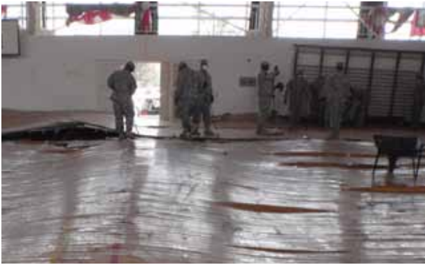
汚泥の除去と床のクリーニング
