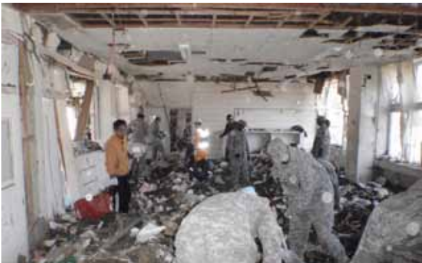
瓦礫等の撤去作業状況
