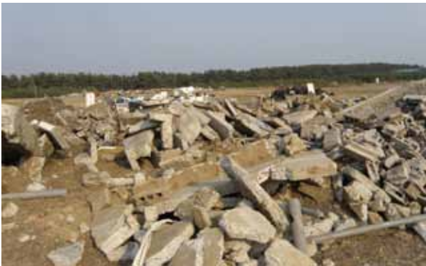
瓦礫一時集積所として使用許可 （三沢飛行場周辺財産の一部）
