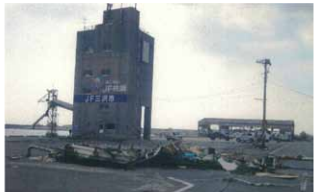
三沢市漁業関係補助事業施設の津波被害
