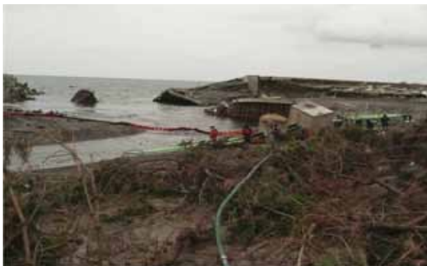
八戸貯油施設の津波による泥水被害
