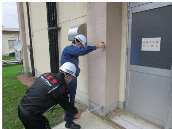
柱の傾斜を調査
