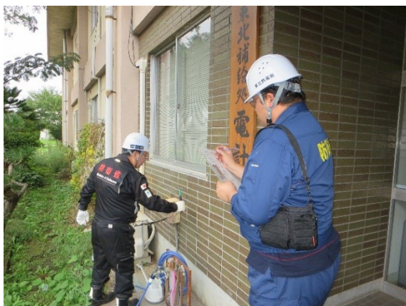
外装材の剥離・ひび割れを調査
