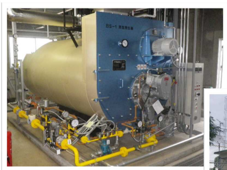
炉筒煙管ボイラー
