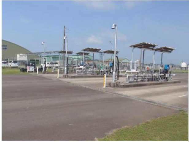
改修後燃料給油スタンド
