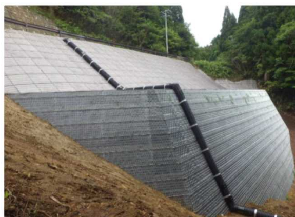
鋼製補強材による擁壁
