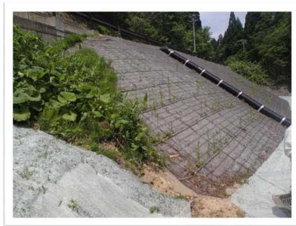
植生シート法面保護
