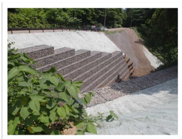
カゴ砕石法面保護
