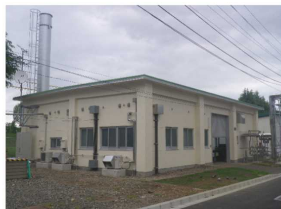
ボイラー室外観
