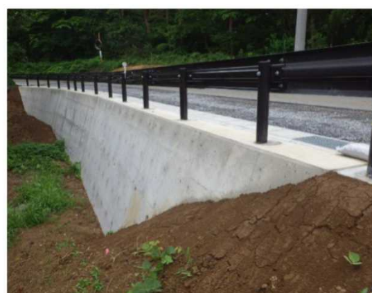
コンクリート擁壁
