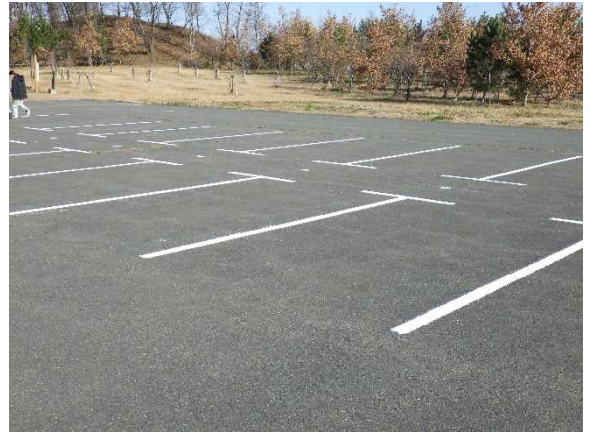
作業後の様子
