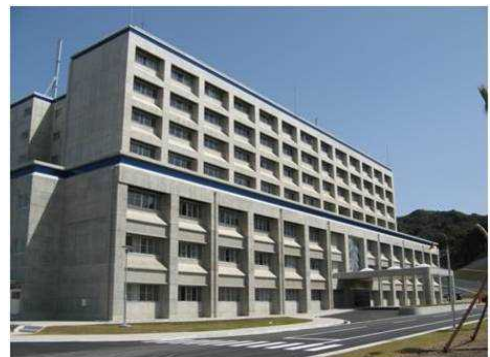
隊庁舎（高知駐屯地）
