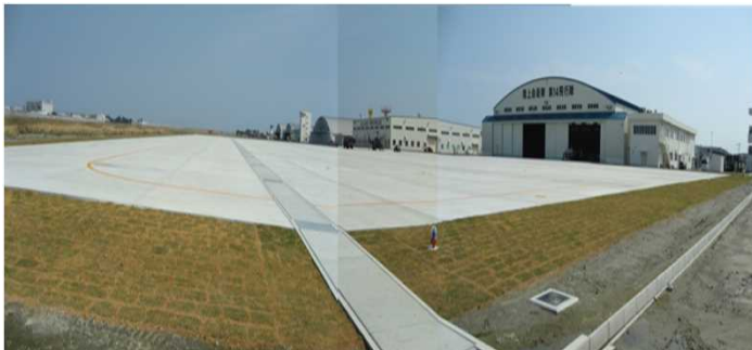
駐機場・格納庫（北徳島駐屯地）
