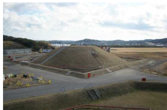
燃料タンク（館山航空基地）
