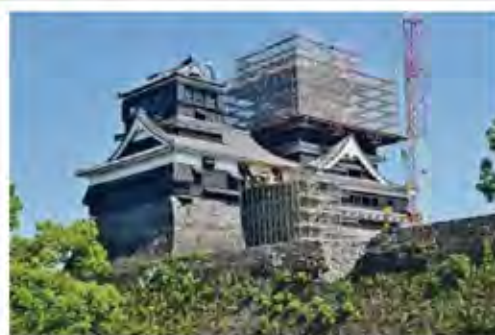
平成28年熊本地震により被害を受け修復中の熊本城
