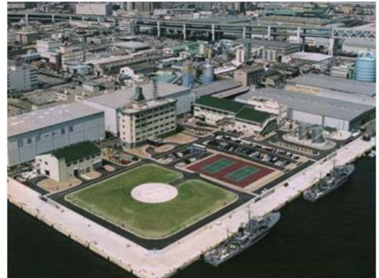
上空からの基地全景
