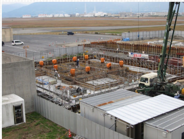
施設の建設工事の様子（イメージ）
