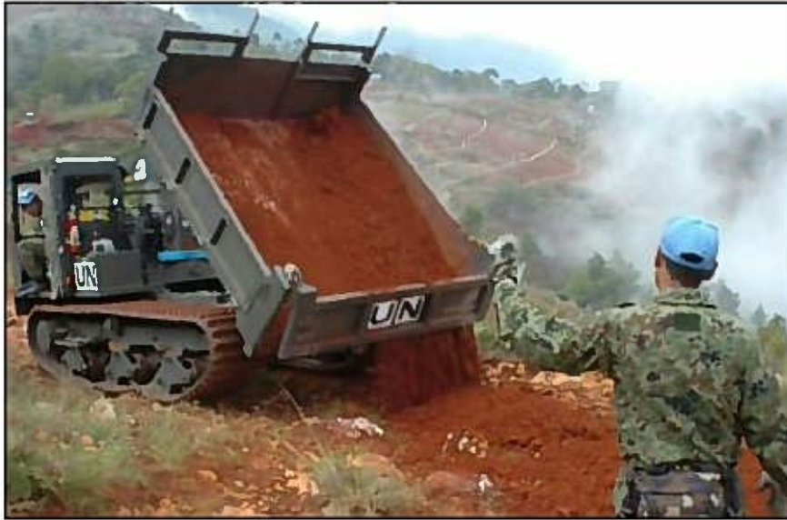
ゴヤビエ山通信塔取付道の整備
