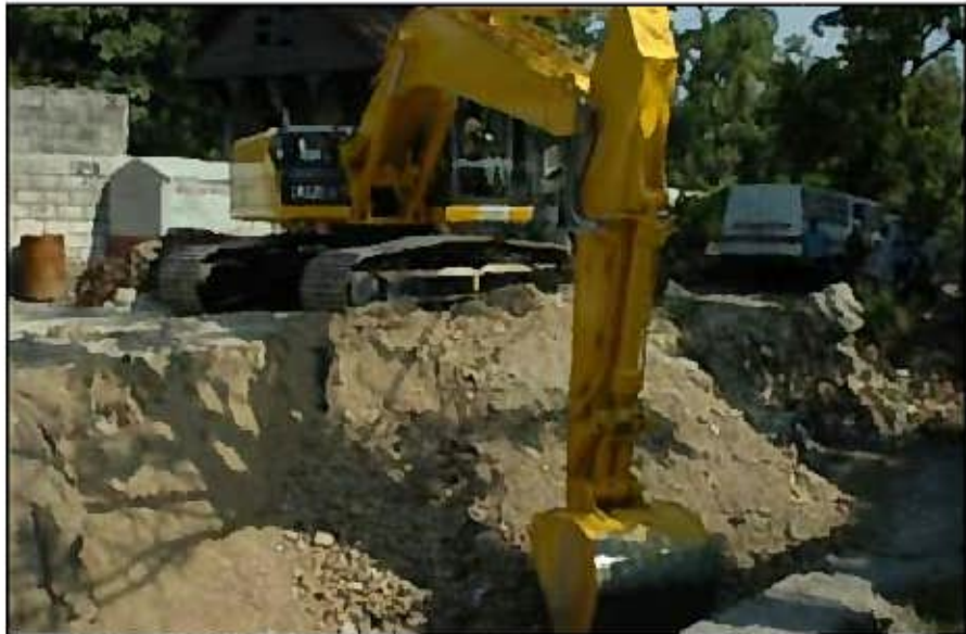
運河の瓦礫除去
