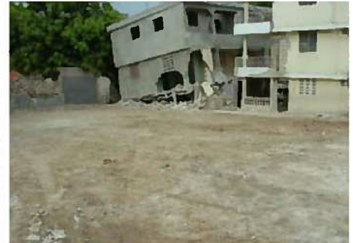
がれき除去・整地完了後
