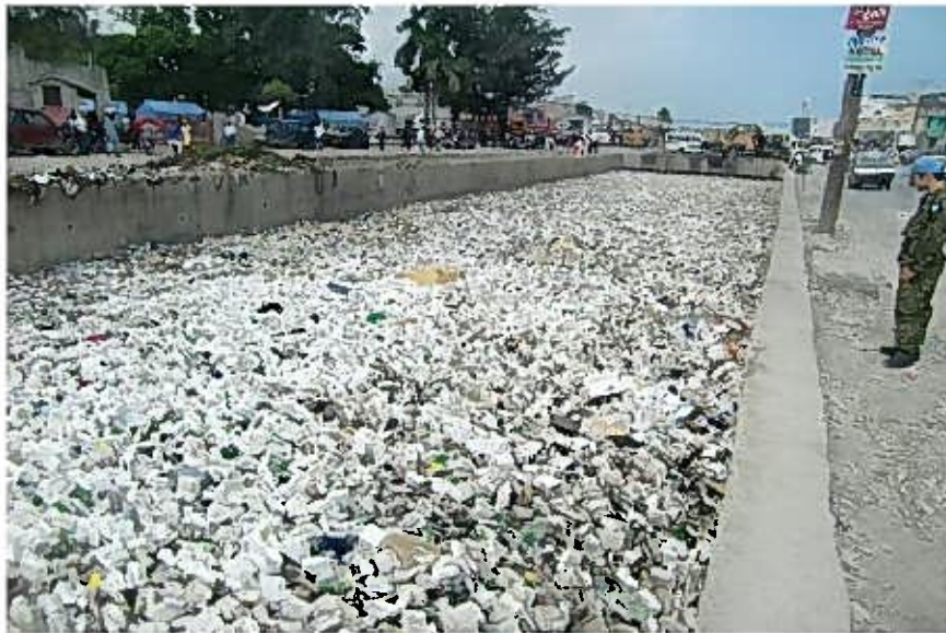
ゴミ・瓦礫の散乱する運河の様子
