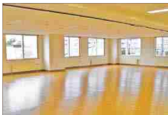
防音サッシ設置
