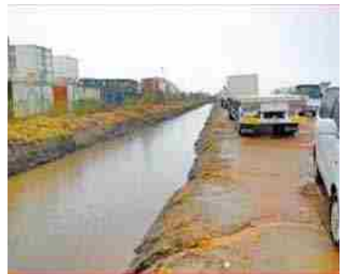
国連施設内雨水排水施設整備
