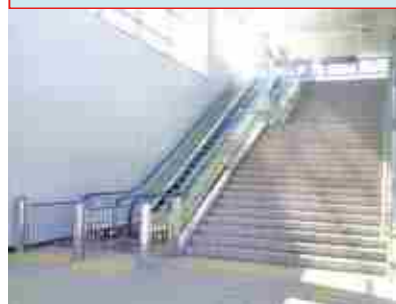
エスカレーターの改修
