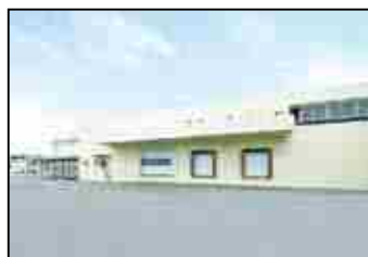
水産物冷蔵施設
