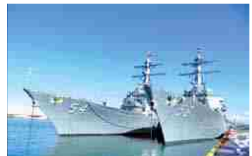
非提供港湾施設使用時の損失補償（米海軍駆逐艦「カーティス・ウィルバー（左）」、「ジョン・S・マッケイン（右）」：苫小牧港）
