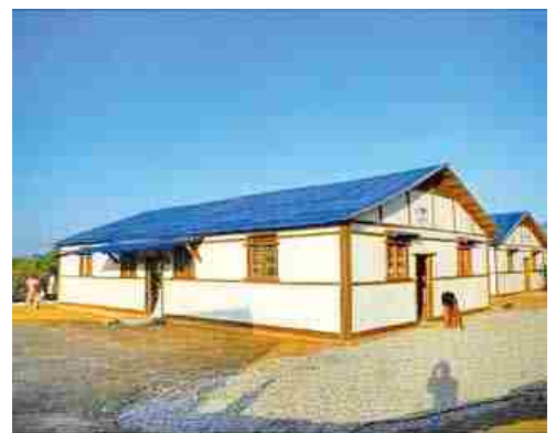
帰還民の一時収容施設建設
