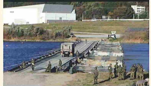
北上川に全通した92式浮橋
