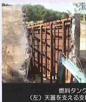
燃料タンクを覆っていた土を除去する様子
