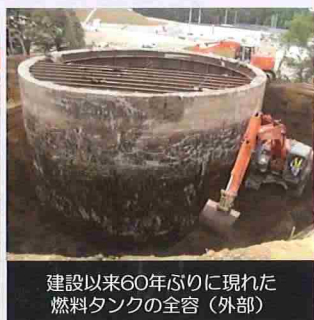
燃料タンクを覆っていた土を除去する様子
