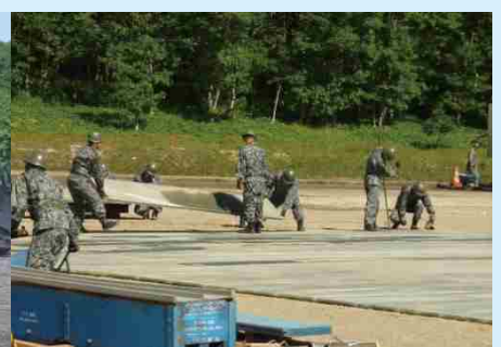
模擬滑走路に応急滑走路復旧マットを敷く隊員
