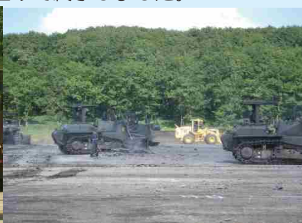
弾痕の埋め戻し状況
