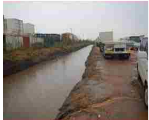
国連施設内雨水排水施設整備
