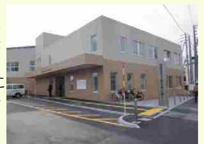
完成した花園コミュニティセンター
