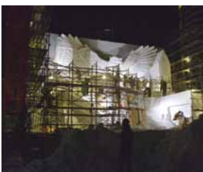
⑧ 夜間作業
