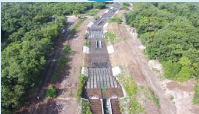
【復旧完了区間】
