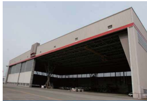
政府専用機格納庫（外観）
