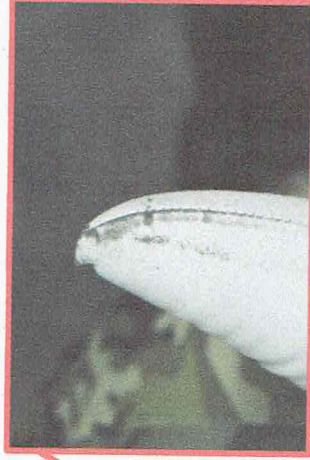
(左) こすれ破損
