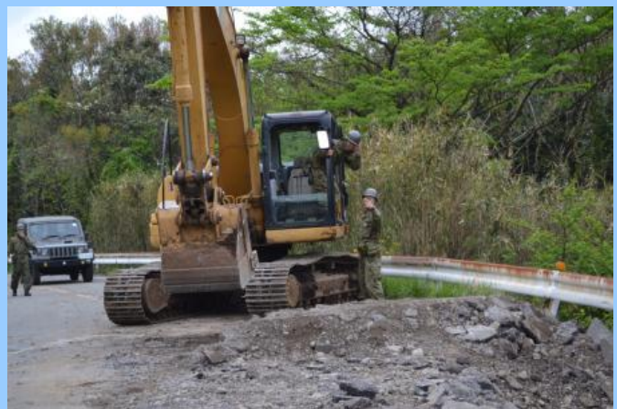
1 8 日 道路啓開 (第 7 施設群：大久保駐屯地)
