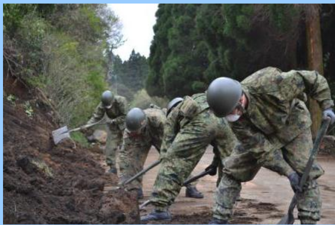
1 8 日 道路啓開 (第 7 施設群：大久保駐屯地)
