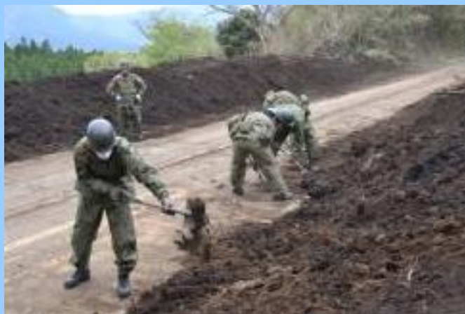
1 8 日 道路啓開 (第 7 施設群：大久保駐屯地)
