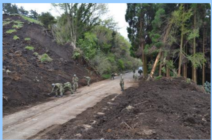
1 8 日 道路啓開 (第 7 施設群：大久保駐屯地)
