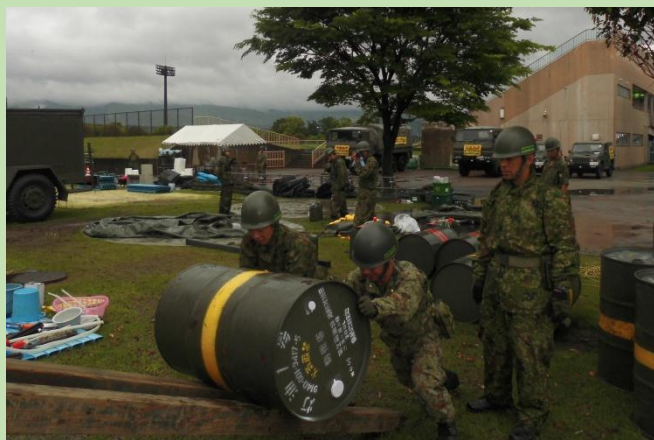
大津運動公園 入浴施設解体 (第 3 後方支援連隊：千僧駐屯地)
