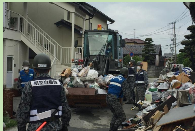
東区沼山津 道路啓開(震災ごみの処理) (航空自衛隊)
