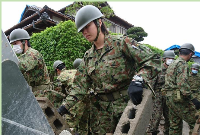
益城町広崎 道路啓開 (第8施設大隊：川内駐屯地)
