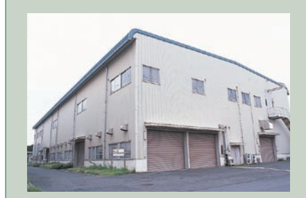
理工学実験棟 ■A～E棟まであり、大型の実験装置や実習工場などがあります。
