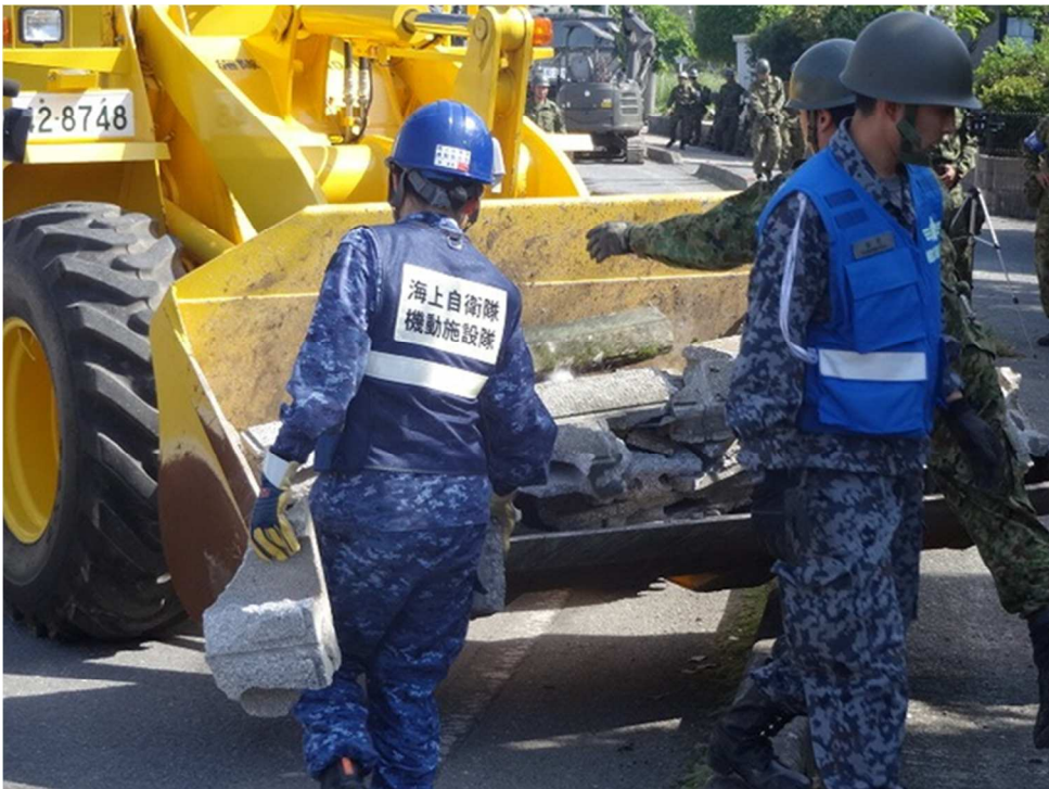
道路の瓦礫を手作業で撤去している様子（4月23日）
