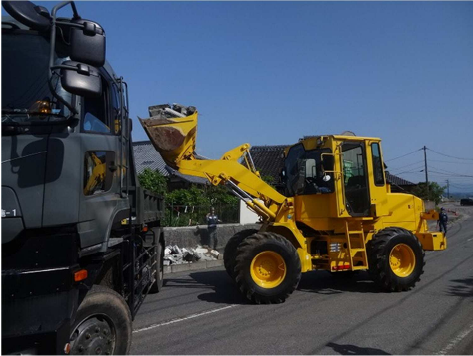
集積した瓦礫をトラックの荷台に乗せるトラクターショベル（4月23日）
