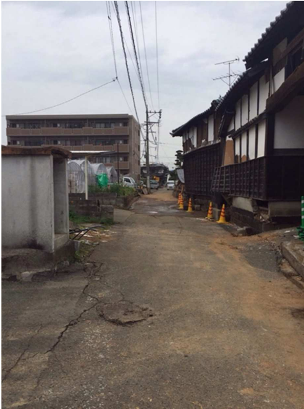
瓦礫撤去終了後の道路（4月23日）
