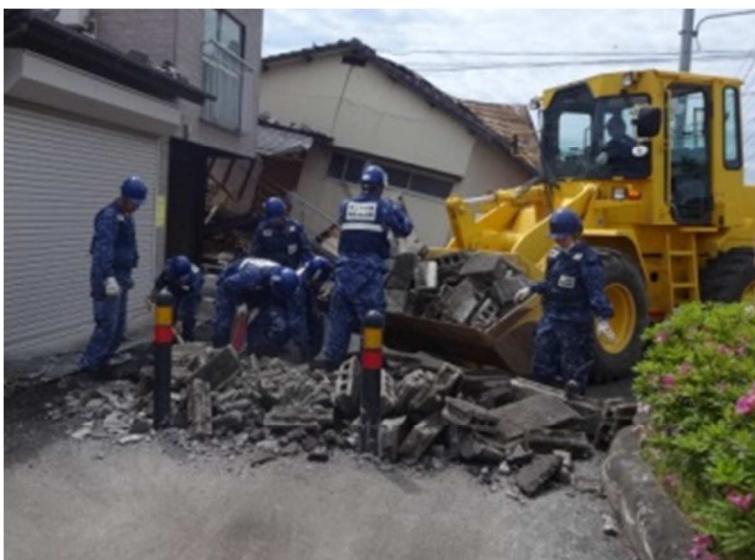
瓦礫積み込みの様子(4月26日)
