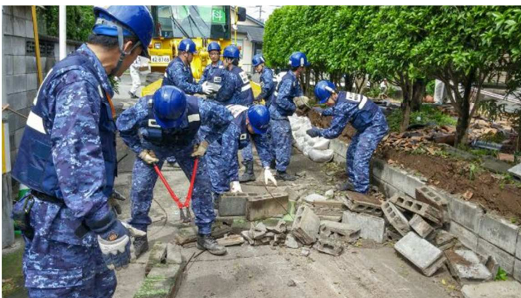
壊れたブロック壁を撤去し、土嚢を積む様子（4月26日）
