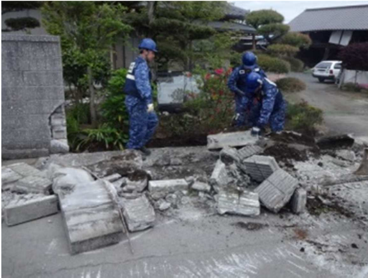
倒れたブロック塀を撤去する様子（4月26日）
