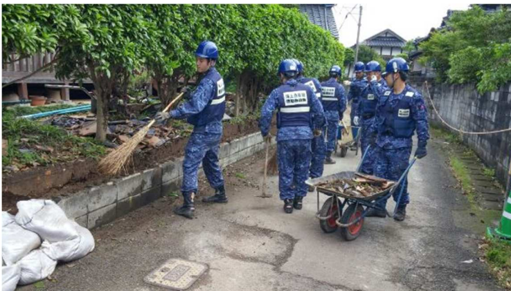
道路脇に土嚢を積む様子（4月26日）
