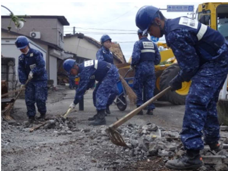
手作業による瓦礫撤去の様子(4月26日)
