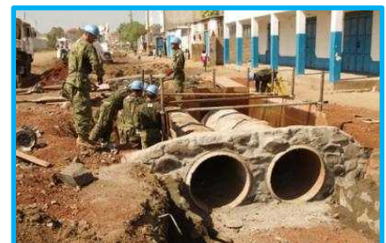
【南スーダンPKOにおける道路整備】
