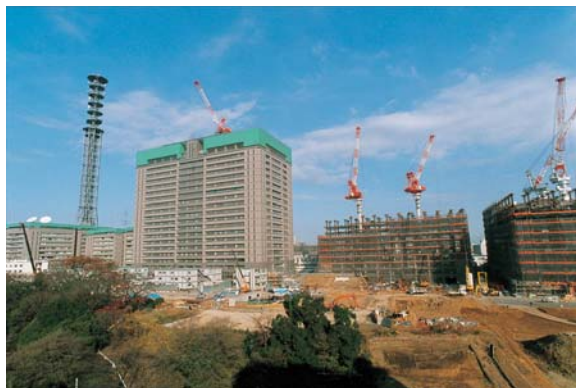
市ヶ谷地区の工事の様子 (提供：朝雲新聞社)
