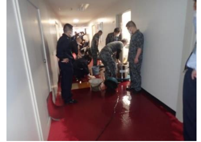
↑ 雨漏りに対応する隊員
