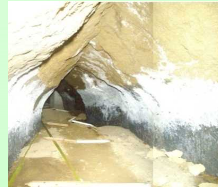
壕の内部を地上から直接確認する手法の検討 (写真は、ボーリング装置で地上から壕まで孔をあけ、 その中にカメラを入れて壕の内部を撮影した状況)
