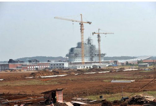
武漢で建設中の空母を模した建造物
