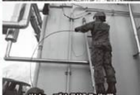
光ケーブル引込み作業
