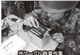
光ケーブル融着作業
