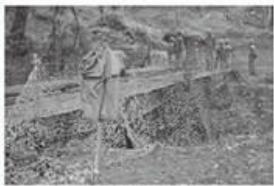
自走架柱橋による橋梁
