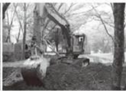
重機による指揮所構築
