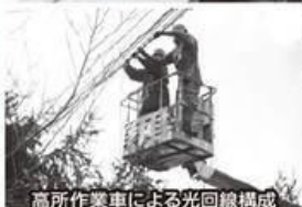
高所作業車による光回線構築
