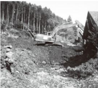
南阿蘇村の国道三五号線、土砂崩れで道路が寸断されたため重機等を使用し道路啓開作業を実施する隊員
