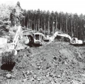
南阿蘇村の国道三五号線、土砂崩れで道路が寸断されたため重機等を使用し道路啓開作業を実施する隊員
