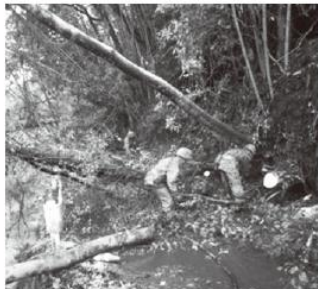
南阿蘇村床瀬川北側において道路啓開のため倒木の伐採作業をする隊員
